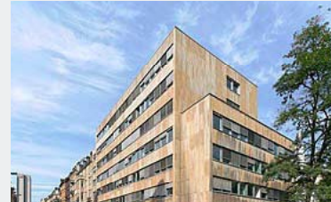
Gutleutstraße 26, Frankfurt am Main
